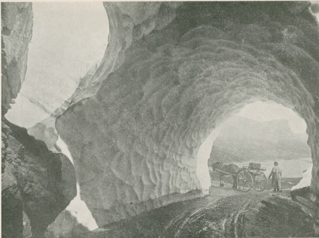
Fig 28. Tidligere snetunnel i Dyrskar i ruten Telemarken—Hardanger, Hordaland fylke. Veien er nu omlagt her.
