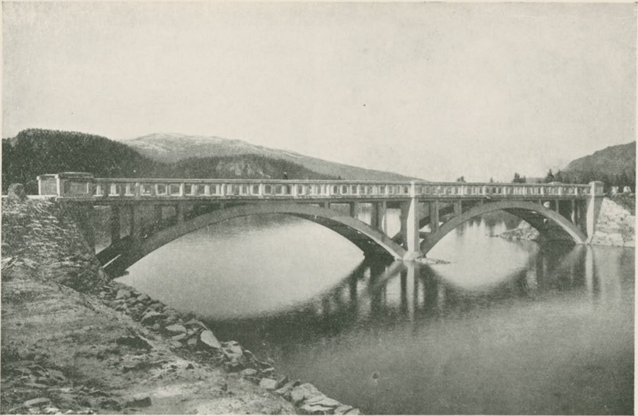
Fig 31. Bogna bro. Nord Trøndelag fylke. 2 spænd à 22,0 m. Kjørebredde 4,0 m. Bygget 1908.
