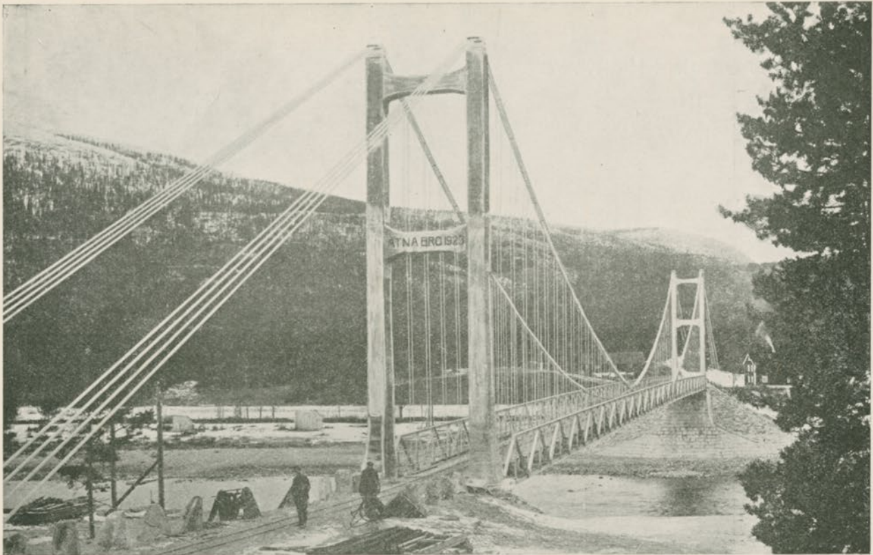
Fig 34. Atna bro. Hedmark fylke. Spændvidde 150 m. Kjørebredde 3,5 m. Bygget 1923.
