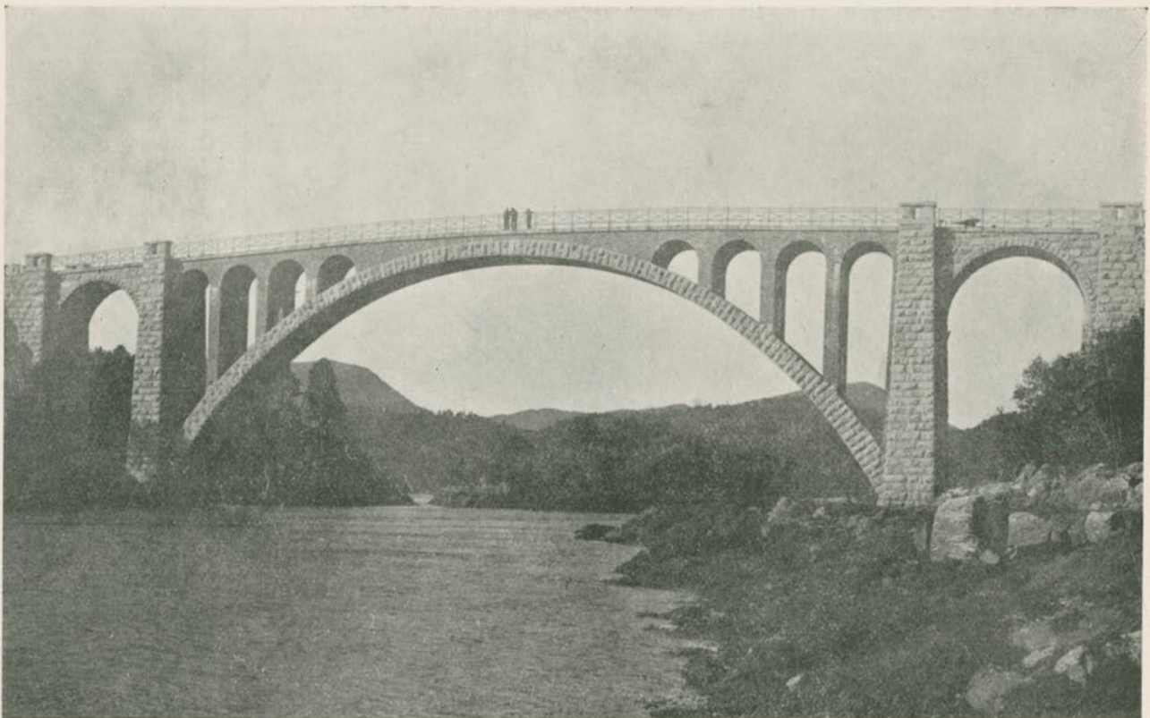
Fig 32. Skodjestrømmen bro. Møre fylke. Spændvidde 57,0 m. Kjørebredde 4,0 m.
